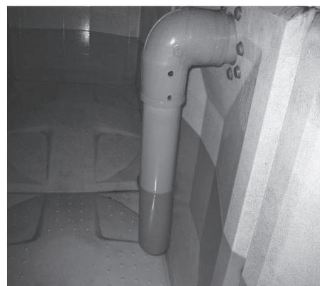
写真1 水没している流入管
