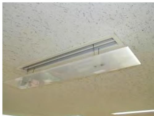
写真 3 吹出口フラップ設置の例
