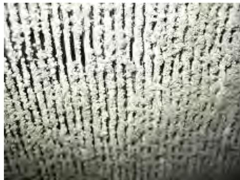
写真 2 汚れた冷温水コイル
