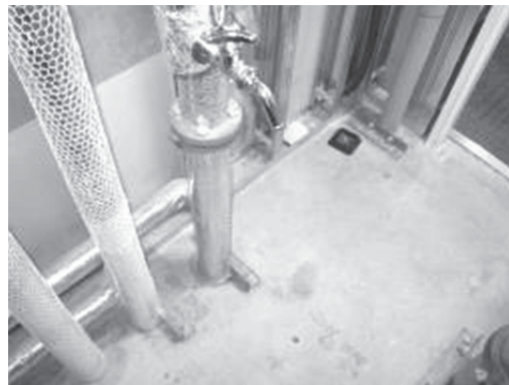
PS に設置された雑用水検水栓
