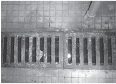
図 17 機械室の排水溝
