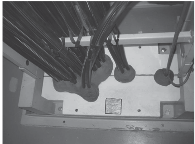
図10 パテによるケーブル貫通部分の穴埋め
