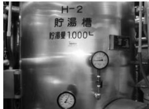
写真 4 給湯用貯湯槽
