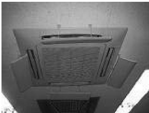
写真5 吹出口フラップ設置の例
