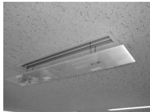
写真5 吹出口フラップ設置の例
