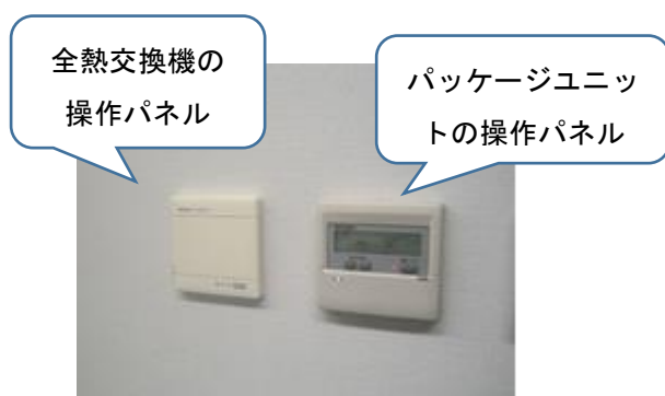
図1 空調機の操作盤例1
