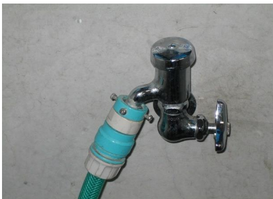
写真1 大気圧式バキュームブレーカ
