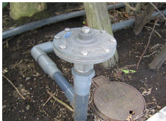
写真2 圧力式バキュームブレーカ
