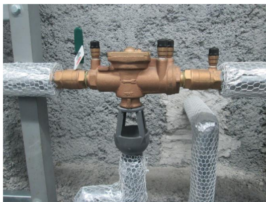
写真3 減圧式逆流防止器
