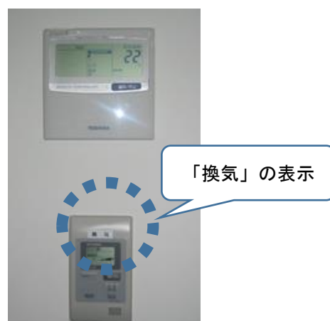
図2 空調機の操作盤例2
