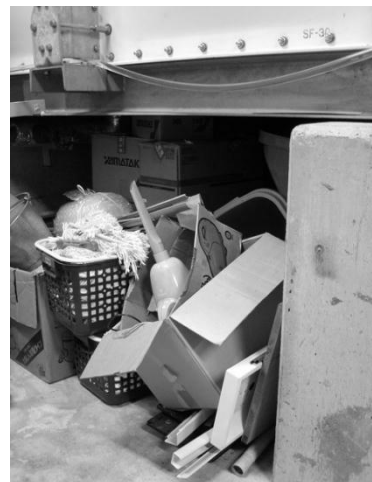
受水槽下部の物置化
