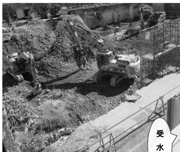
隣接している工事現場
