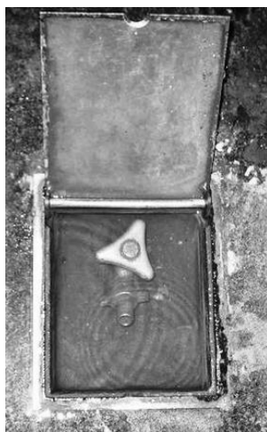
浸透性が失われ水没した散水栓
