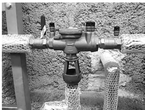
写真 3 減圧式逆流防止器
