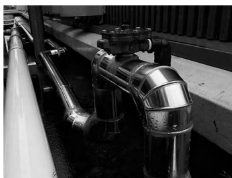
写真 2 圧力式バキュームブレーカ
