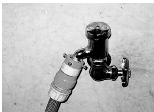
写真 1 大気圧式バキュームブレーカ
