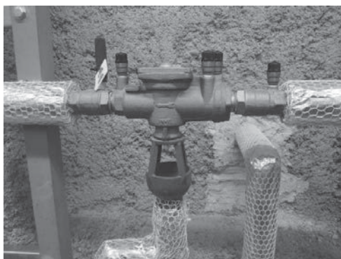
写真 3 減圧式逆流防止器
