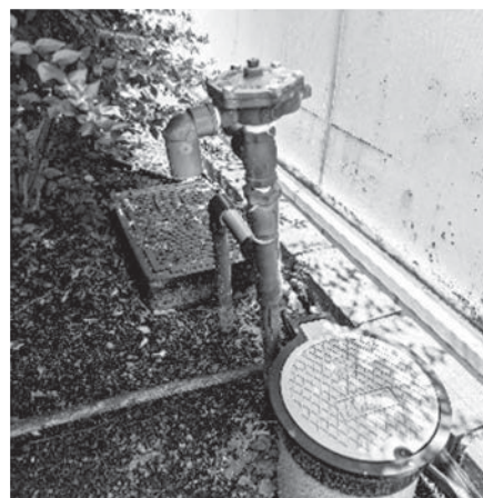
図 自動灌水装置へのバキュームブレーカ設置例
