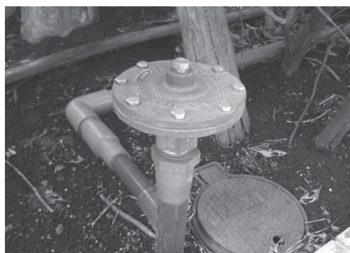
写真2 圧力式バキュームブレーカ
