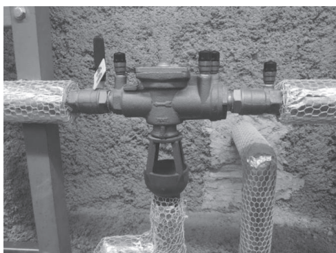
写真3 減圧式逆流防止器
