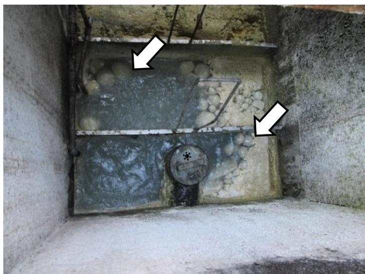
浮遊した油脂分の毎日除去、底にたまったゴミや油脂の掃除などの日常管理を実施しにくい状況でした。さらに、ばっ気装置を稼働していたため、内部が攪拌され、油脂の分離が阻害されていたと考えられました。
