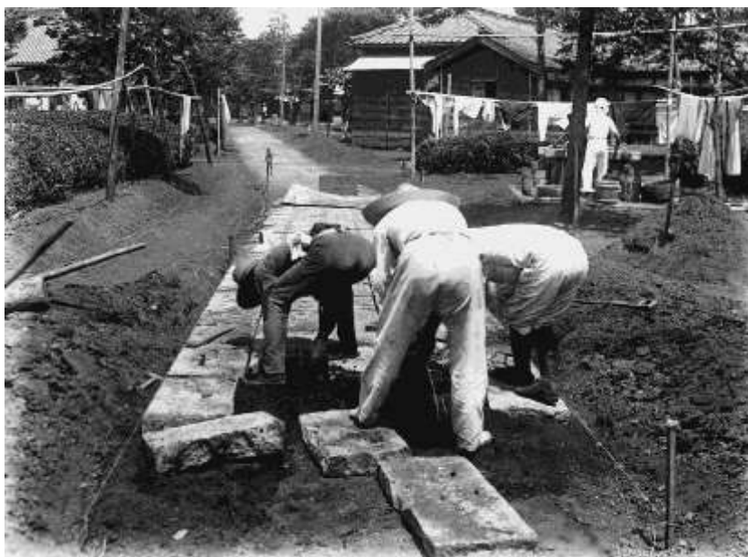
敷石敷設作業
