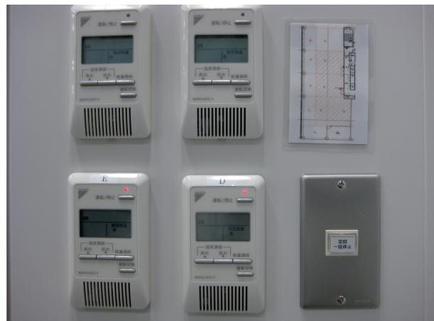
図4. 室内にある個別制御空調稼動スイッチ
