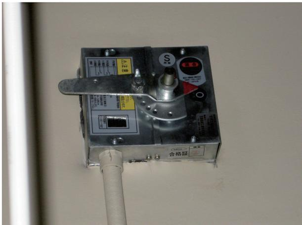
図3. 外気量調整ダンパ
