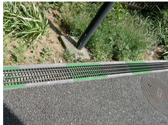
写真1. 側溝蓋に塗った防水材料 (緑色の部分)
