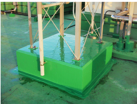
写真3. 防水材料塗布後のコンクリート台座
