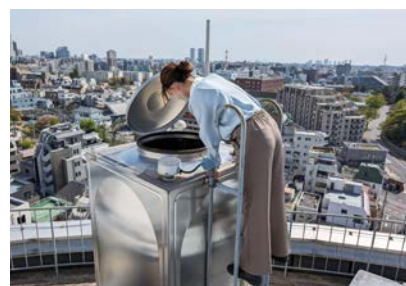
（建築物）屋上の高置水槽の検査
