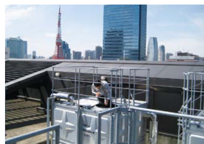
（建築物）屋上の高置水槽の検査
