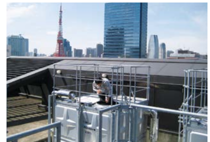
(建築物) 屋上の高置水槽の検査
